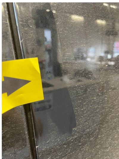
1.2 Flere p-bulker ( rettes ut og poleres over )
