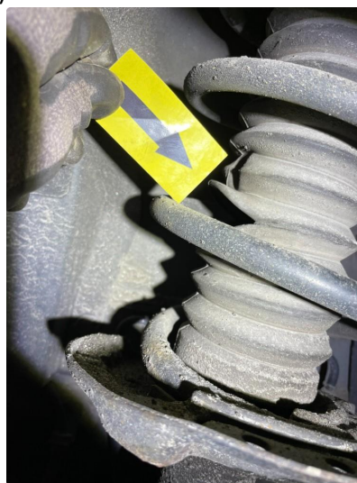
4.1 Støvmansjett defekt ( byttes )
