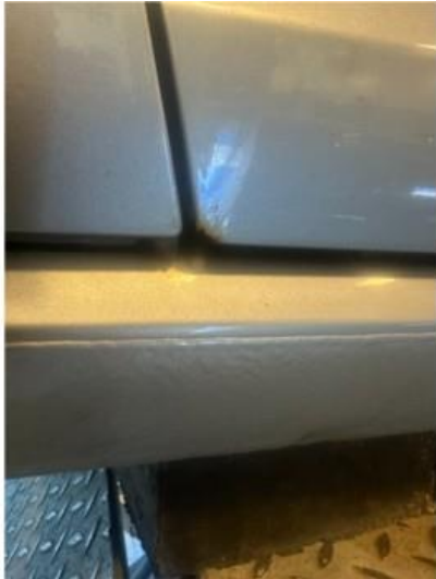
1.2 Noe korrosjon på hjørne av venstre dør foran
