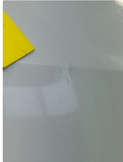
1.1 Litt korrosjon i dør venstre bak
