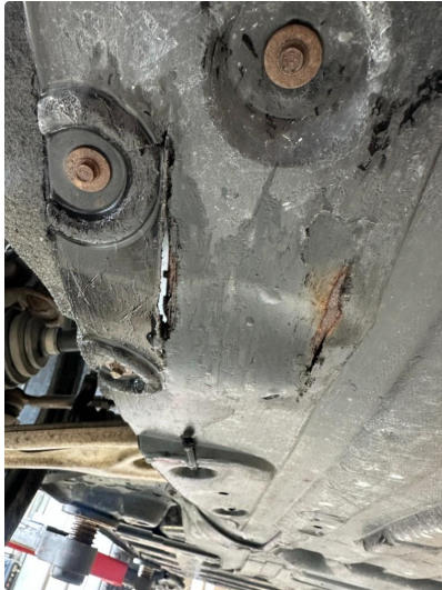
1.1 Noen sprekker i beskyttelsesplate under bilden
